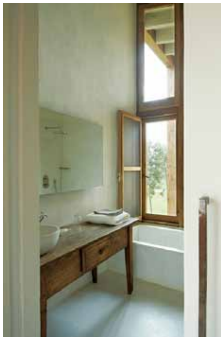
Finestres practicables de fusta de roure francès massís amb acabat de lasur a l'aigua deixant el porus de la fusta obert.
